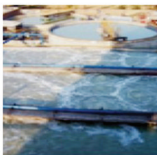
Effluent Treatment Plant (ETP)
